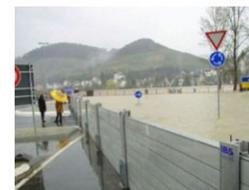
仮設止水壁の設置例 (日本仮設株式会社HPより)
